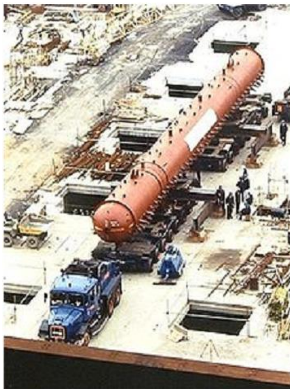
شکل ۷-۱) نمونه ای از درام به کار رفته در بویلر [۴]
