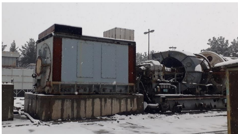
شکل ۳-۱: ژنراتور ۴۴ مگاوات آمپری ساخت شرکت مارلی
