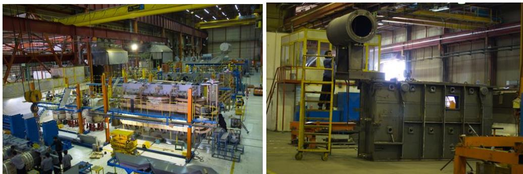
شکل ۲-۹: تصاویری از کارخانه شرکت ایران ترانسفو
