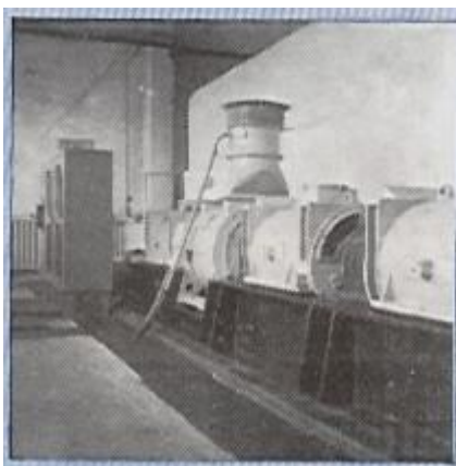
شکل ۱-۱۴: سه ژنراتور اتصال کوتاه ۳۹۰ کیلوولت آمپر، ۴۰۰ ولت که به سه ترانسفورماتور تک‌فاز ۴۰۰ کیلوولت به ۲۵ ولت متصل شده‌اند [۸]
