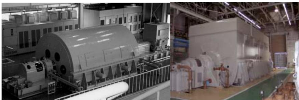
شکل ۱-۳۵: ژنراتورهای اتصال کوتاه شرکت Toshiba، ۱۶۰۳ مگاوات آمپر سمت چپ، ۸۸۸۰ مگاوات آمپر سمت راست [۱۳]
