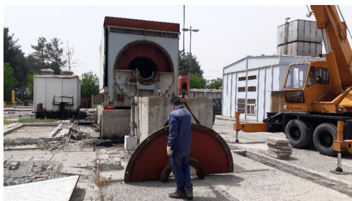
شکل ۳-۴: عملیات بازکردن براکت‌های جلو و عقب ژنراتور مارلی واحد ۲۶ جهت بررسی داخل آن
