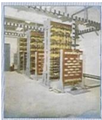
شکل ۱-۱۳: راکتورهای تنظیم‌کننده جریان اتصال کوتاه [۸]
