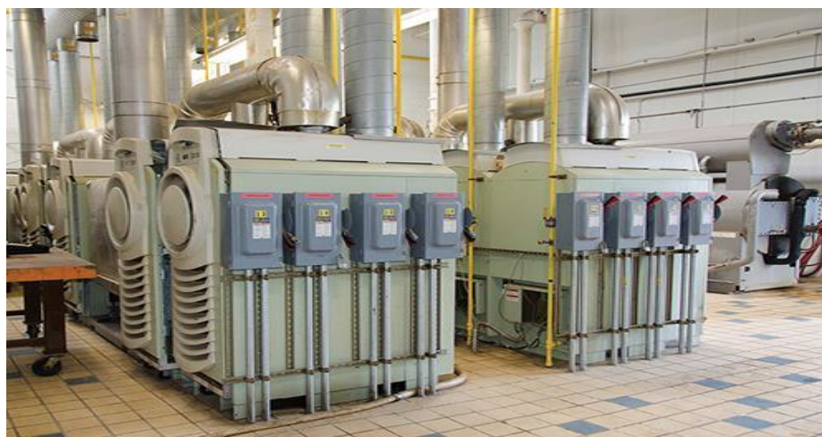
شکل ۲۲.۲ سیستم CCHP مبتنی بر میکروتوربین [۱۴]
