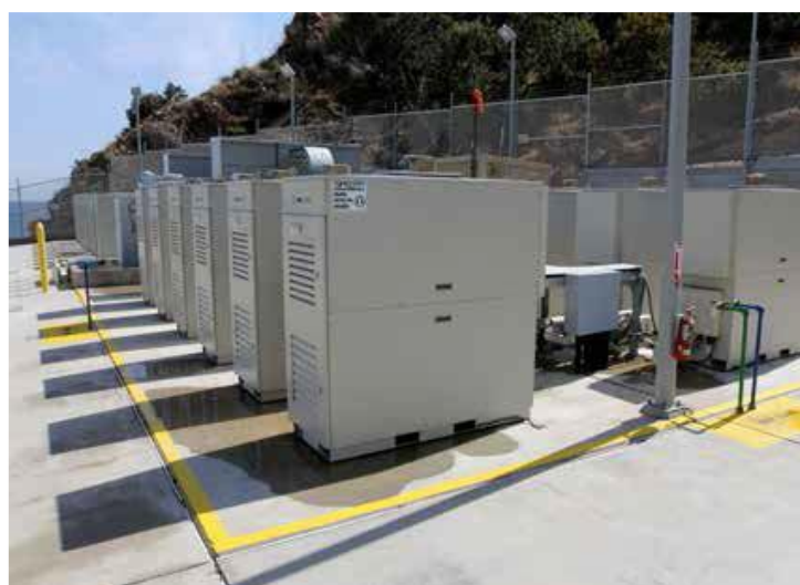
شکل ۲۳.۲ سیستم تولید همزمان ۱/۵ مگاواتی تشکیل شده از ۲۳ میکروتوربین ۶۵ کیلوواتی [۱۵]
