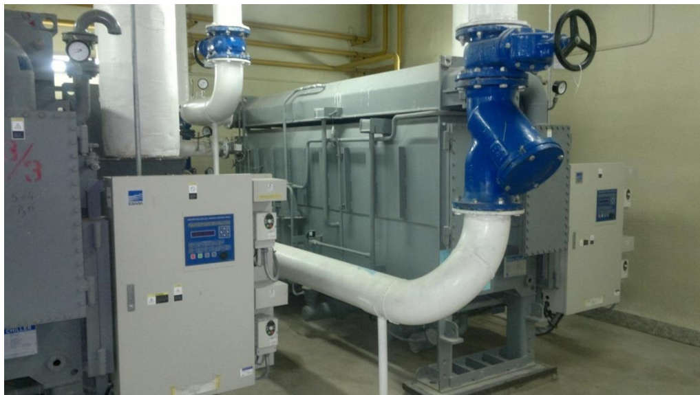
شکل ۵۰.۲ نمایی از چیلرهای جذبی
