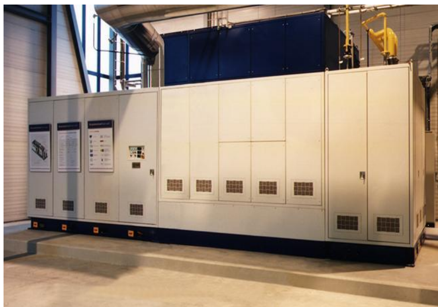
شکل ۳۳.۲ نیروگاه ۱۰۰ کیلوواتی پیل سوختی با راندمان ۴۶ درصد [۱۹]
