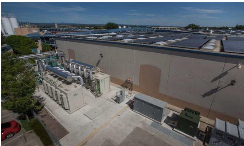
شکل ۲۴.۲ سیستم تولید همزمان ۲ مگاواتی تشکیل شده از ۲ پکیج میکروتوربین ۱ مگاواتی [۱۵]
