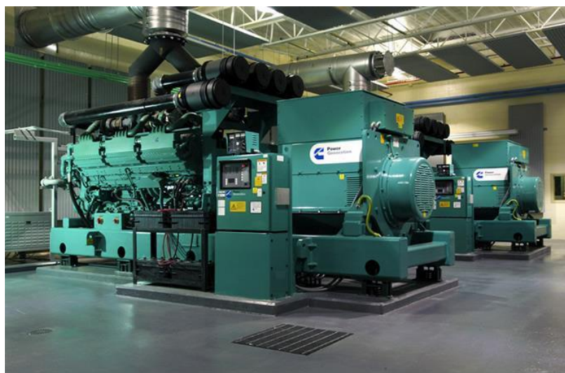
شکل ۱۴.۱ سیستم تولید همزمان با محرک اولیه دیزل [۱۰]
