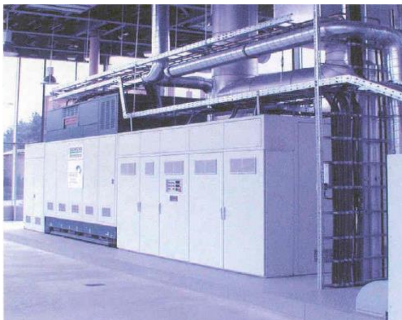
شکل ۳۱.۲ نیروگاه ۱۱۰ کیلوواتی پیل سوختی با رانندمان ۴۶ درصد [۱۸]
