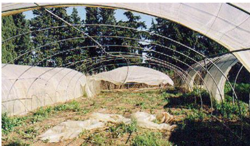
شکل ۵.۱ سازه ضعیف گلخانه که بر اثر باد تخریب گشته است [۴]
