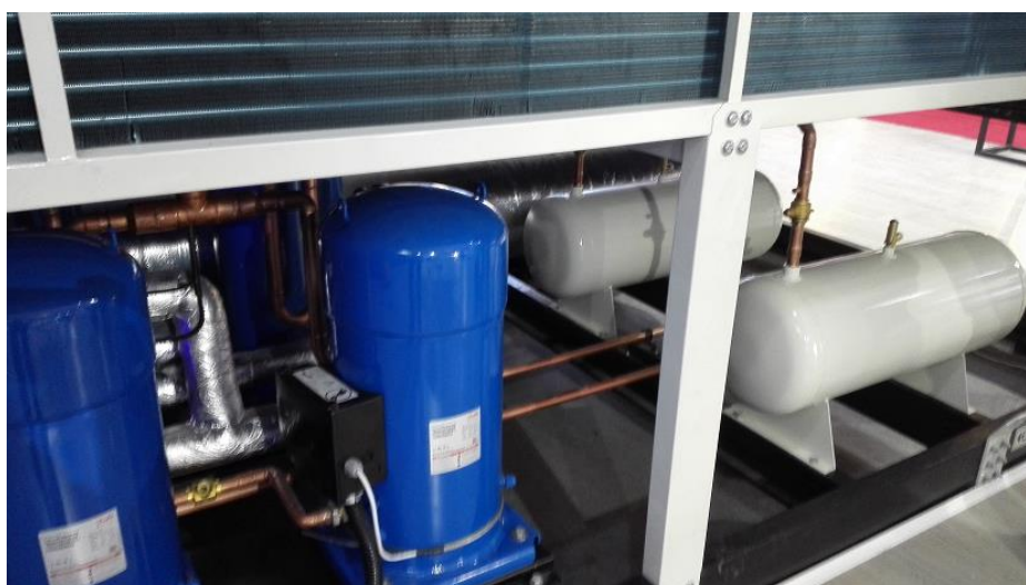
شکل ۴۵.۲ نمایی از چیلر تراکمی با کمپرسور اسکرال
