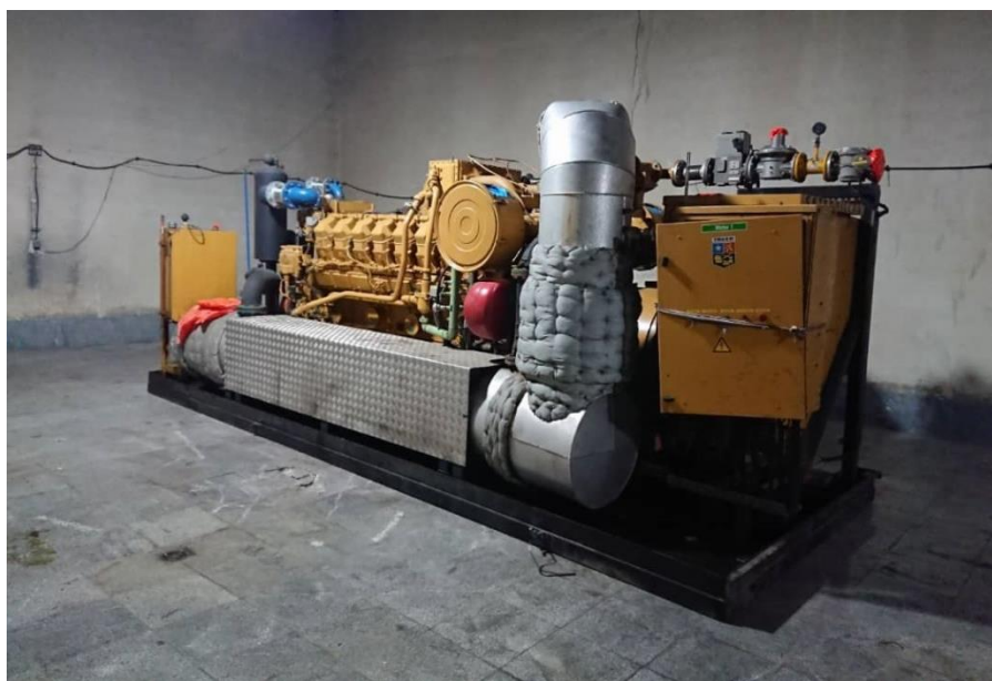
شکل ۱۱.۱ موتور گازسوز ۱۶ سیلندر با توان الکتریکی خروجی ۹۰۰ کیلووات [۷]
