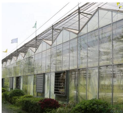
شکل ۸.۱ گلخانه پلی کربنات [۷]
