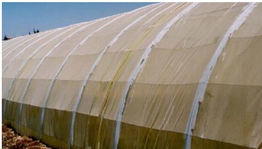
شکل ۱۹.۱ عایق‌کاری اجزای فولادی با رنگ سفید پلاستیکی [۴]
