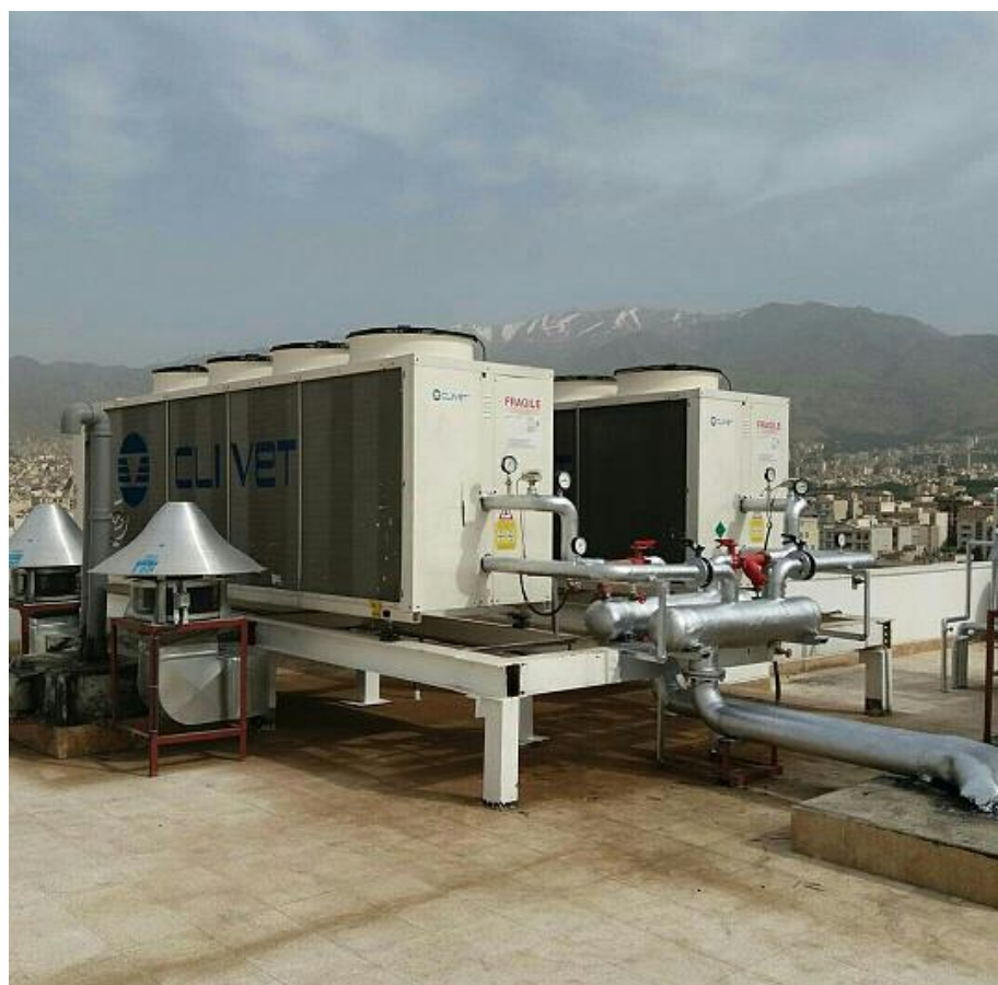
شکل ۴۰.۲ نمایشی از چیلر تراکمی هوا خنک یکپارچه
