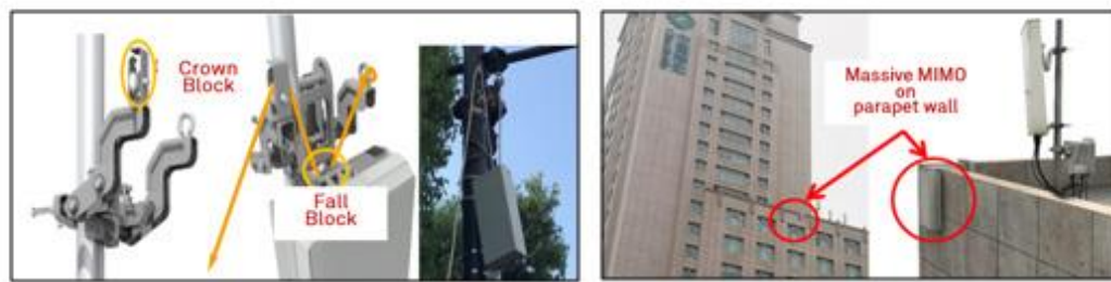
شکل ۳-۱ نصب واحدهای Massive MIMO در سازه‌های شهری [۵]
