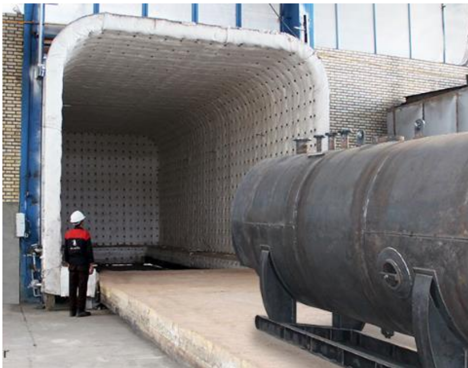
شکل ۴-۳: قرار دادن کل سازه داخل کوره جهت انجام تنش زدایی حرارتی
