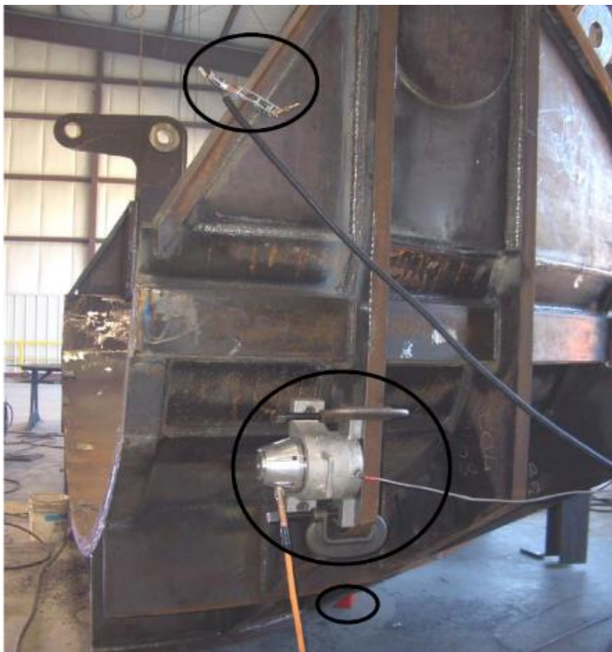
شکل ۴-۱۷: استفاده از تنش زدایی ارتعاشی جهت رفع اعوجاج یک سازه با وزن ۲۵ تن
