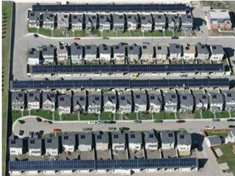
شکل ۴-۶: نمایی از خانه‌های پروژه Drake Landing Solar [۲۷]
