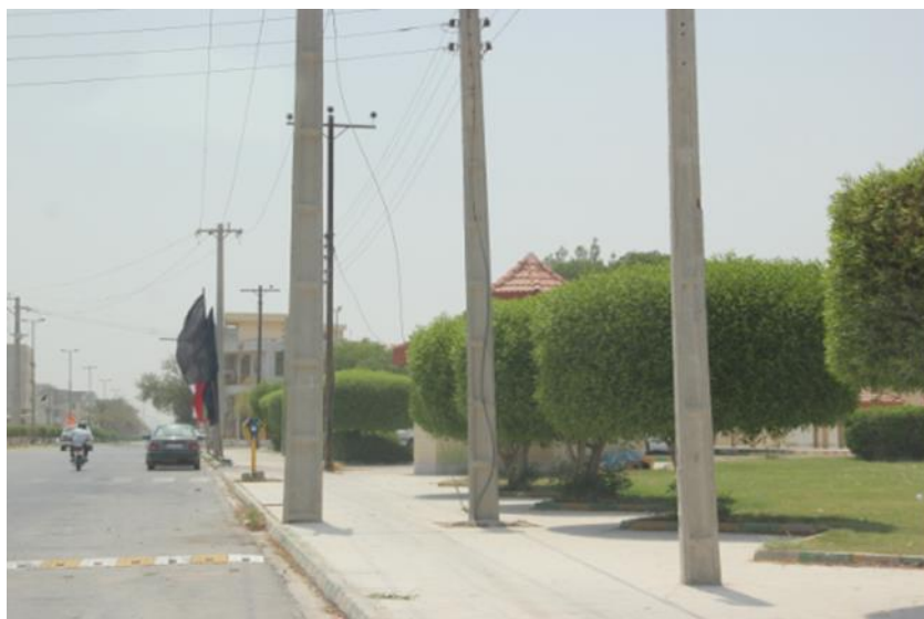
شکل (۱-۱) نمایی از پایه های بتنی برق در سطح شهر [۱]
