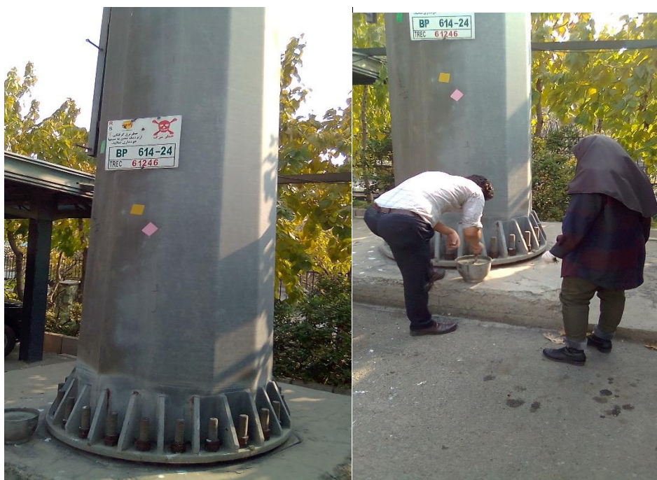
شکل (۴-۱) اعمال ملات خودترمیم بر پایه بتنی
