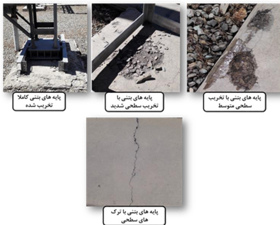
شکل (۱-۵) انواع تخریب های شناسایی شده در پست از گل
