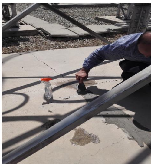
شکل (۲-۱) ترمیم پایه های بتنی در پست انتقال از گل
