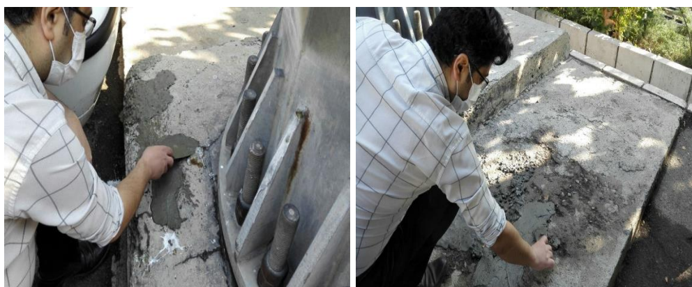
شکل (۴-۲) استفاده از ملات خودترمیم حاوی نانوسیلیکا و باکتری ترمیم کننده جهت ترمیم پایه بتنی
