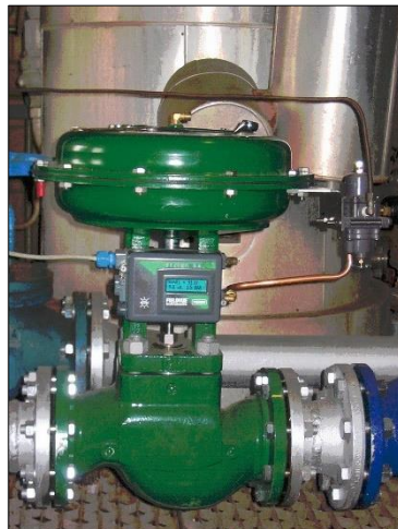
شکل ۲۴-۱. یک شیر کنترل از نوع شیر کروی با عملگر نیوماتیکی و موقعیت‌دهنده
