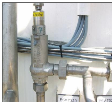
شکل ۲۶-۱. شیر ایمنی مخزن اکسیژن فشرده
