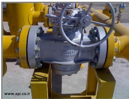
شکل ۱۹-۱. شیر سماوری سایت پمپاژ نفت کرمان
