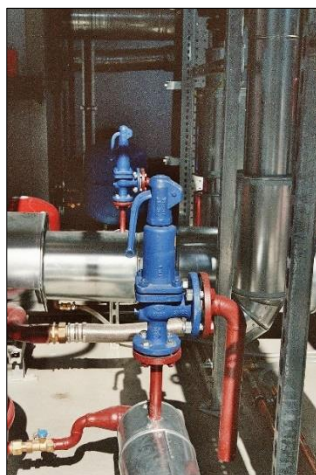
شکل ۲۵-۱. نمونه‌ای از یک شیر فشارشکن
