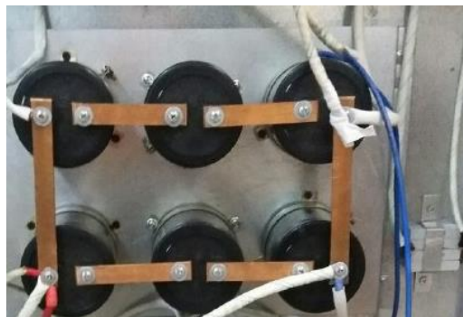
شکل ۲۳-۴: اتصال مقاومت تخلیه شارژ خازن به لینک DC
