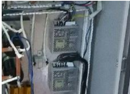
شکل ۴۱-۴: منابع تغذیه کمکی بردهای اینورتر خروجی
