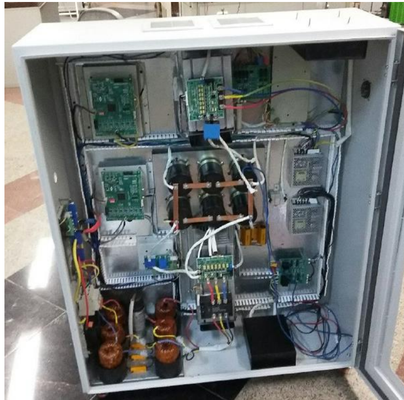
شکل ۴-۳۴: پیاده‌سازی تابلو سیستم دینامومتر
