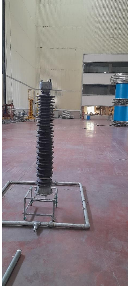
شکل (۷-۳): نمایی از مقره سرامیکی اتکایی پست ۱۳۲ کیلوولت مورد استفاده در سیستم شستشوی آزمایشگاهی
