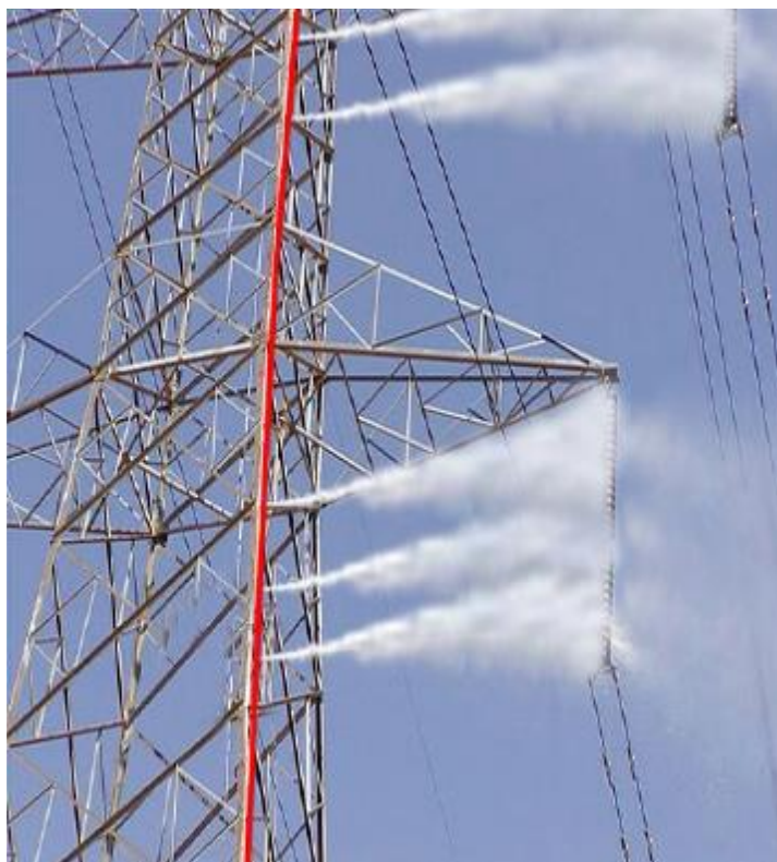
شکل (۷-۱) نمایش از پاشش آب در روش شستشوی ثابت یک دکل توسط شرکت Wilorton
