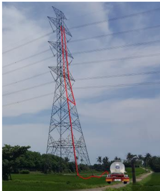
شکل (۱-۶): نمایشی از سیستم آب رسانی یک دکل ۵۰۰kV در نوع اول شستشو ثابت شرکت Wilorton
