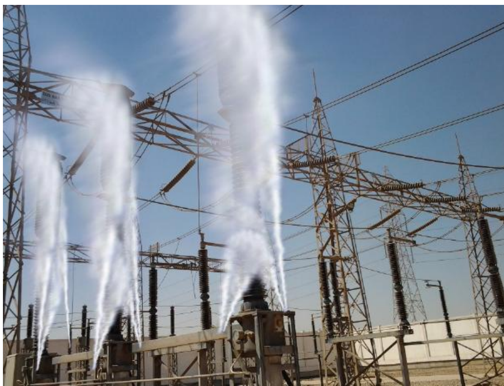
شکل (۱-۲): یک نمونه سیستم شستشو ثابت نصب شده توسط شرکت wilorton
