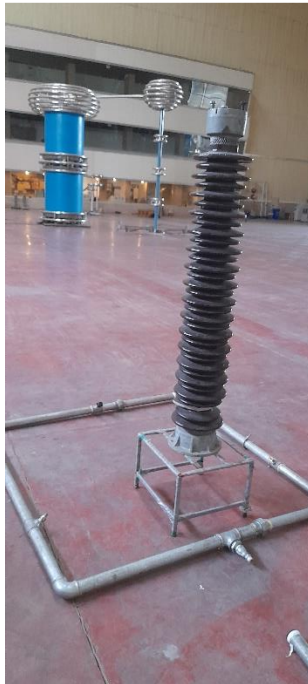
شکل (۳-۴): نمایی از لوله کشی مورد استفاده در سیستم شستشوی آزمایشگاهی
