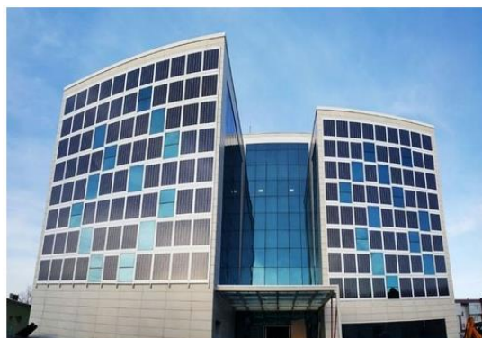
شکل (۲-۹) - نمایی از کاربرد فتوولتائیک در ساختمان
