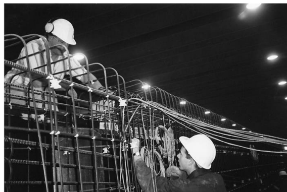
شکل ۴-۶ نمونه ای از استفاده فیبر نوری بصورت مدفون در بتن
