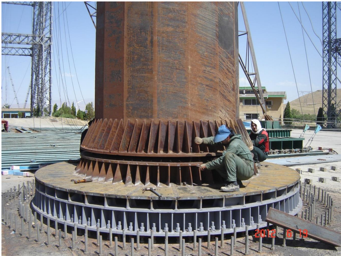
شکل ۷-۴ رابط نصب بستر آزمون شماره ۳
