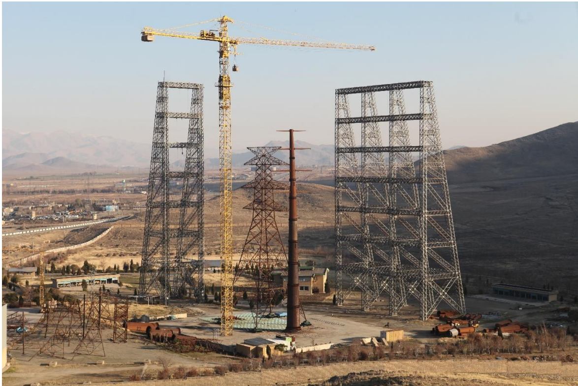
شکل ۶-۷ تاور کرین 20 \times 85 پتن و برج‌های کمکی طولی و عرضی
