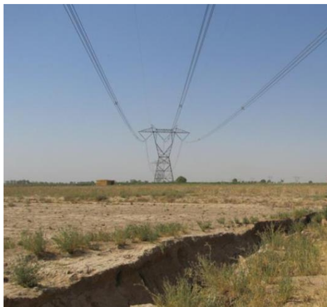
شکل ۱-۱۴ نزدیکی خطوط انتقال برق به شکاف های ایجاد شده در اثر فرونشست
