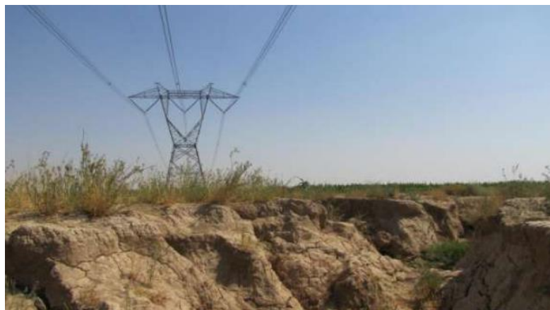
شکل ۴-۴ تهدید دکل های انتقال نیرو توسط فرونشست ایجاد شده در حریم خط انتقال دشت ورامین [۱۹۲]
