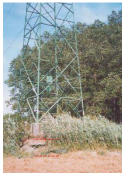
شکل ۳-۴ اثر فرونشست بر دکل برق (حوزه رودخانه آرنو، ایتالیا) [۱۹۲]
