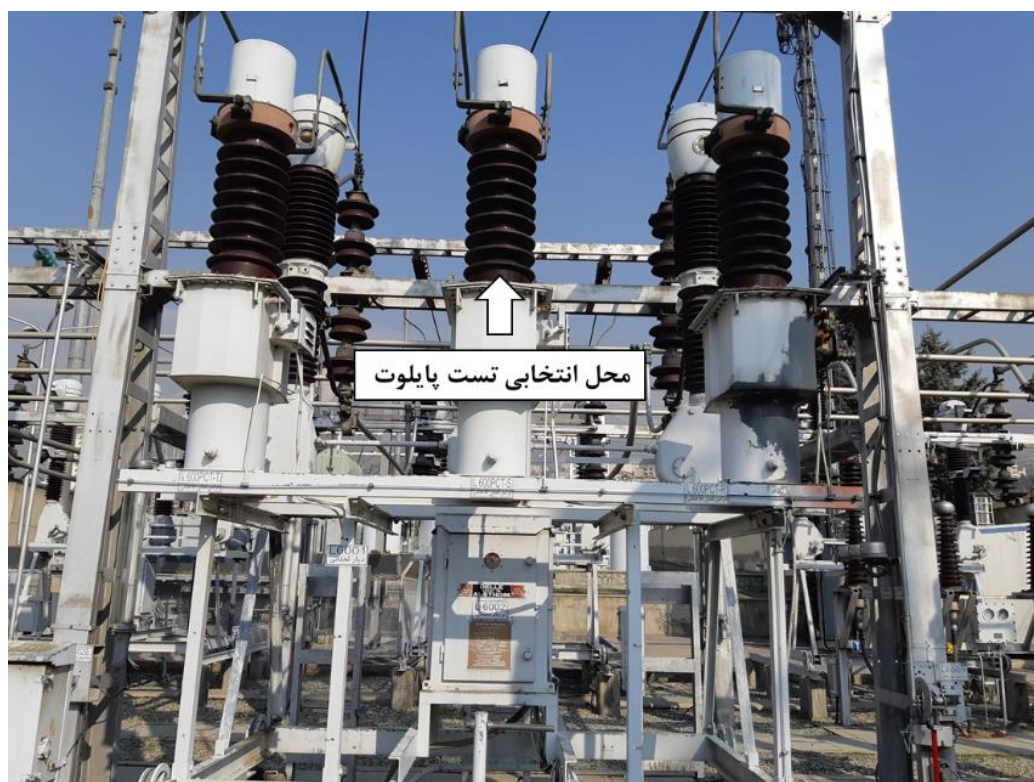
شکل ۴-۵- محل انتخابی برای انجام تست پایلوت پوشش در سطح ایزولاتور PT در خط محلاتی پست ازگل
