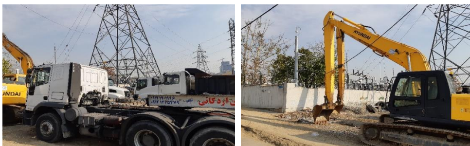
شکل ۴-۲- تصاویری از پارکینگ ماشین آلات سنگین در مجاورت دیوار جنوبی پست ازگل
