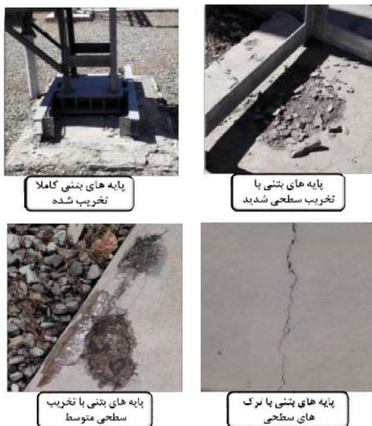
شکل ۴-۱۲- انواع تخریب‌های شناسایی شده در پست ازگل
